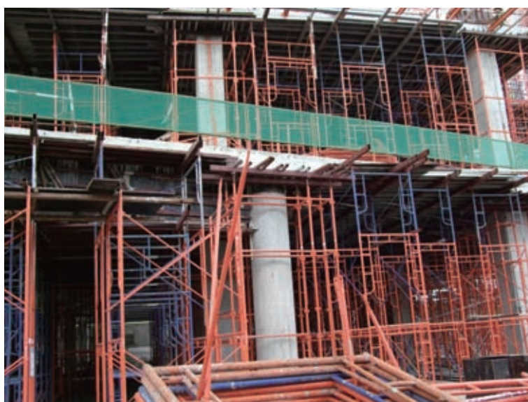
ショッピングセンター建設現場
