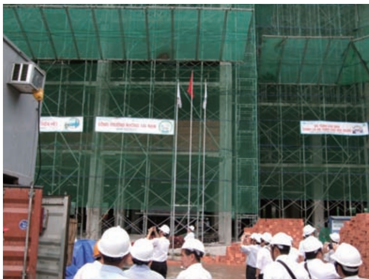
マンション建設現場
