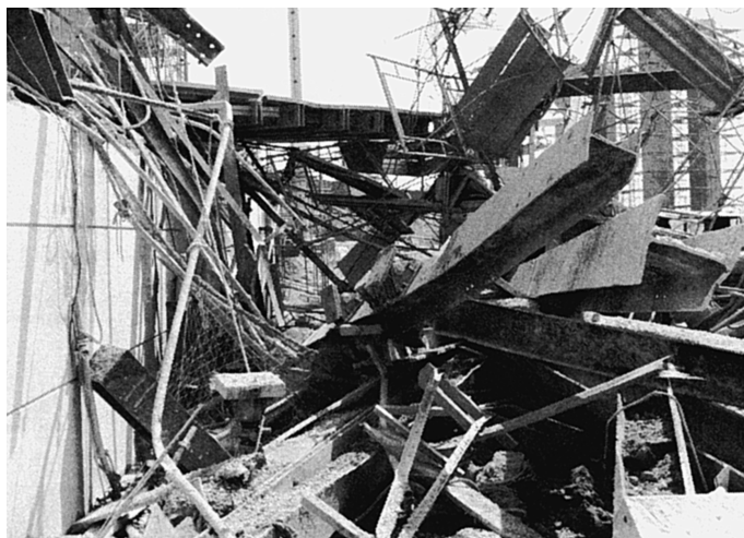
図1.1.1 支柱の座屈による倒壊の例
