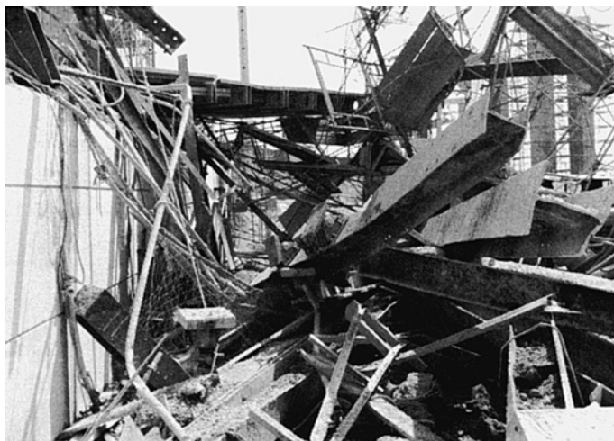
図1.1.1 支柱の座屈による倒壊の例
