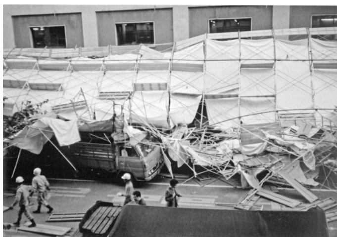
図1.1.2 強風による倒壊の例
