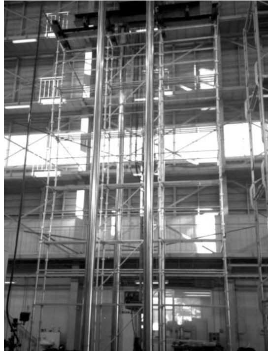
くさび緊結式足場の実大試験例
